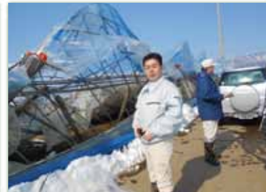
▲雪害被害現地調査(東御市)
